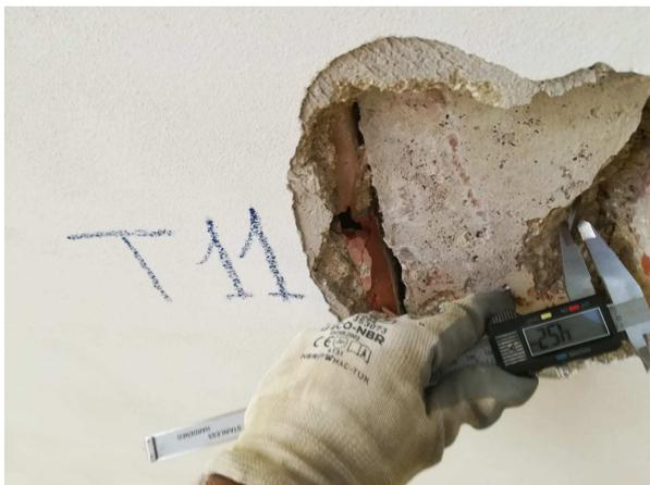
**Figura 9 – Esame diretto sul travetto in c.a.**
